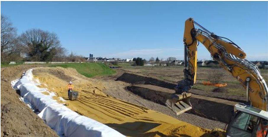
Montage d'un filtre granulaire par épaisseur
